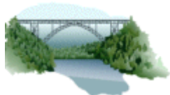
Die Müngstener Brücke
